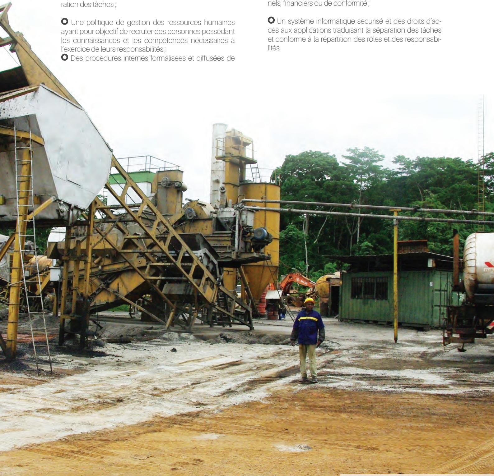
Une station de fabrication de béton bitumineux
