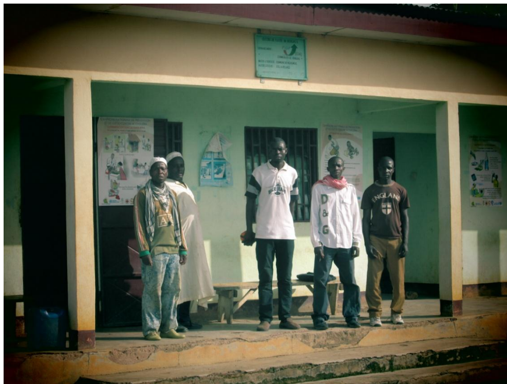
Photo 5 : Etat d'un centre de santé intégré de Demgoya
