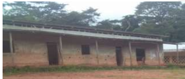
Photo 3 : Salle de classe d'une école Publique inachevée
