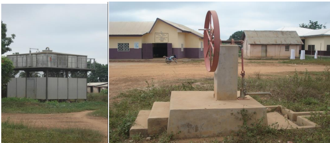
Photo 12 et 13 : Station Scann- water et forage en panne au cœur de l'espace urbain de NSEM
