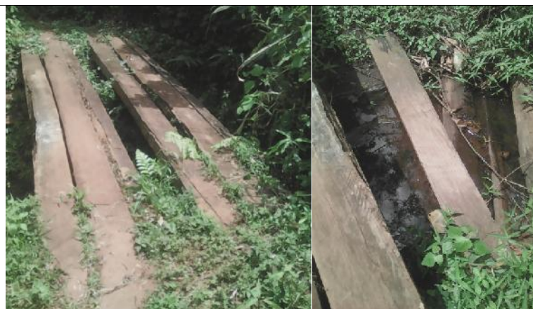
Photo 6 : Pont et point de passage
