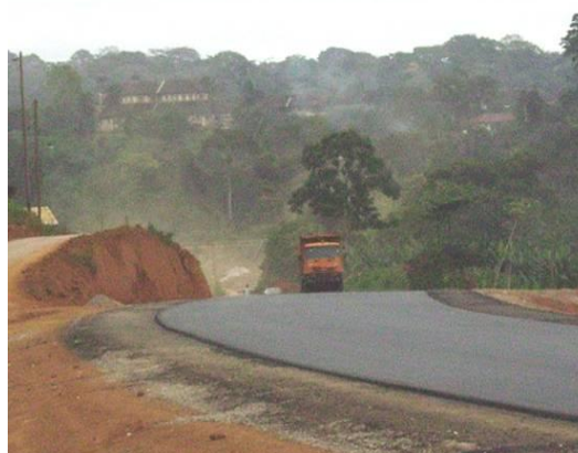
Photo 15: Une vue de la route
