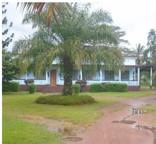
Photo 12: Une vue du collège Stoll
