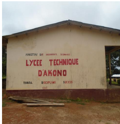
Photo 11: Une vue du lycée technique d'Akono
