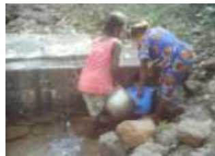
Photo 26 : Une source aménagée avec le deuxième tuyau détruit
