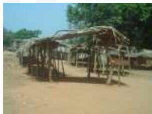
Photo 15 : Hangar de marché à Bédobo
