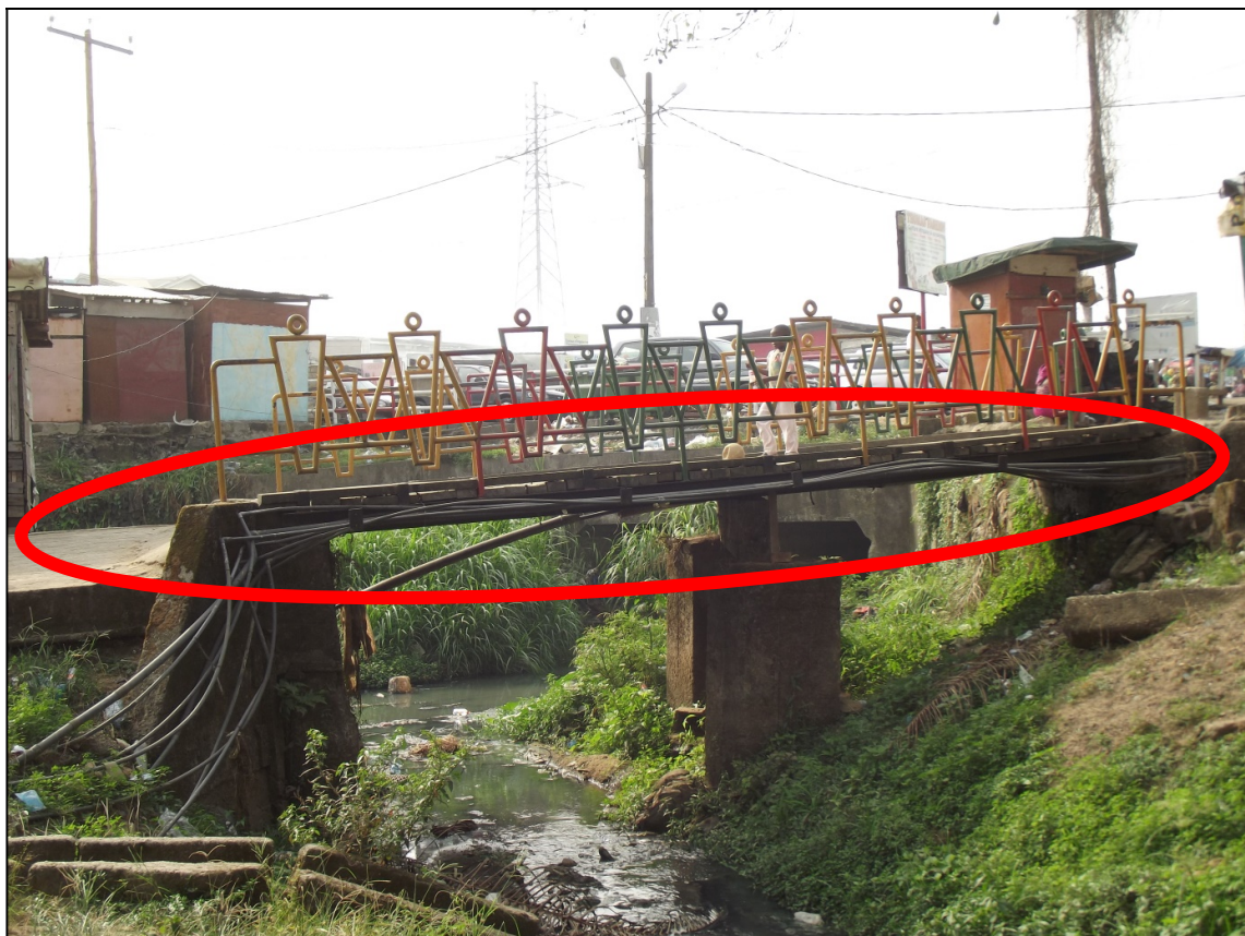
Photographie n° 3 : Des connexions informelles réalisées par les habitants sur le réseau de la CDE
